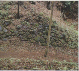
③ 御前曲輪西堀の石垣
