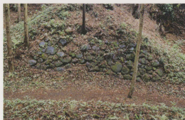
③ 御前曲輪西堀の石垣
