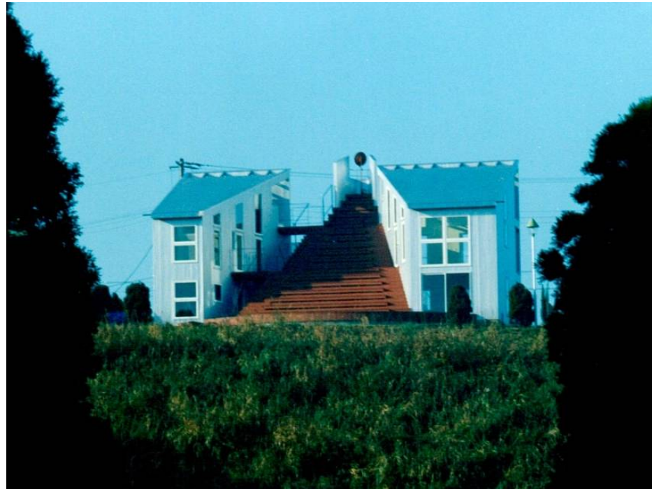
裏より大階段を見る
