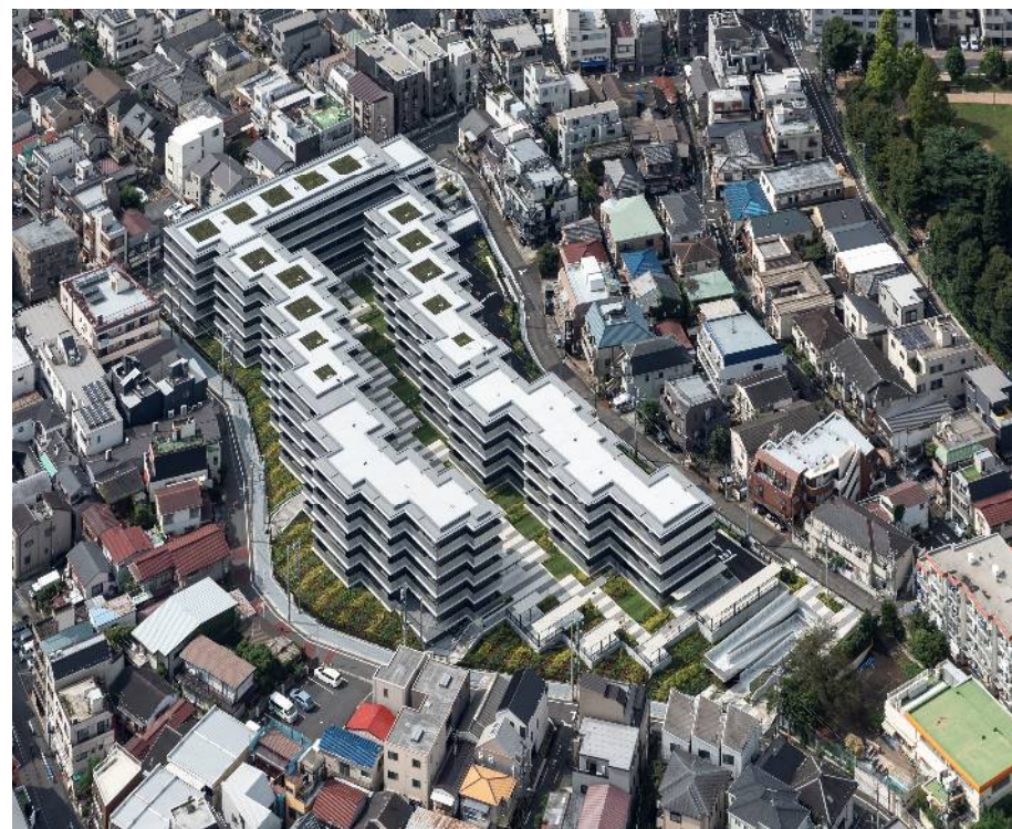
北側から見る
