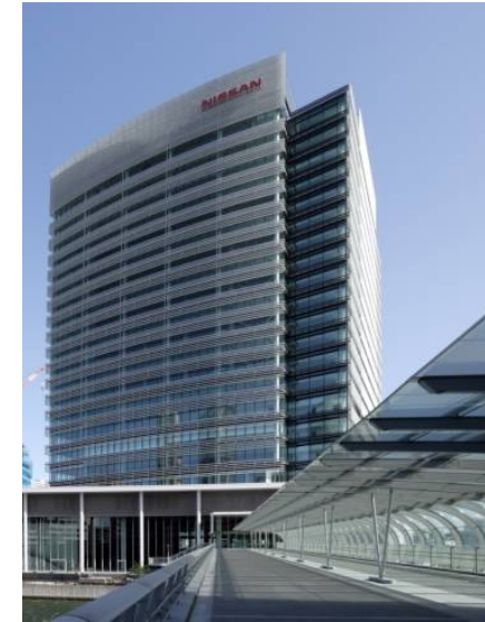
日産本社ビル
