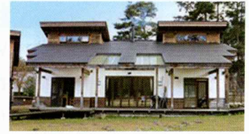
2016年4月 3号棟竣工
