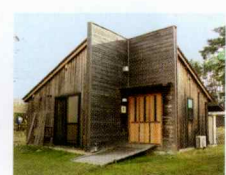
2014年浴室棟完成
