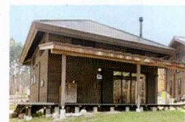
2014年10月 2号棟完成
