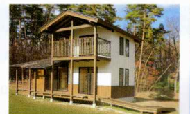
2020年6月5号棟竣工
