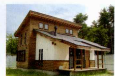
2015年9月 4号棟竣工
